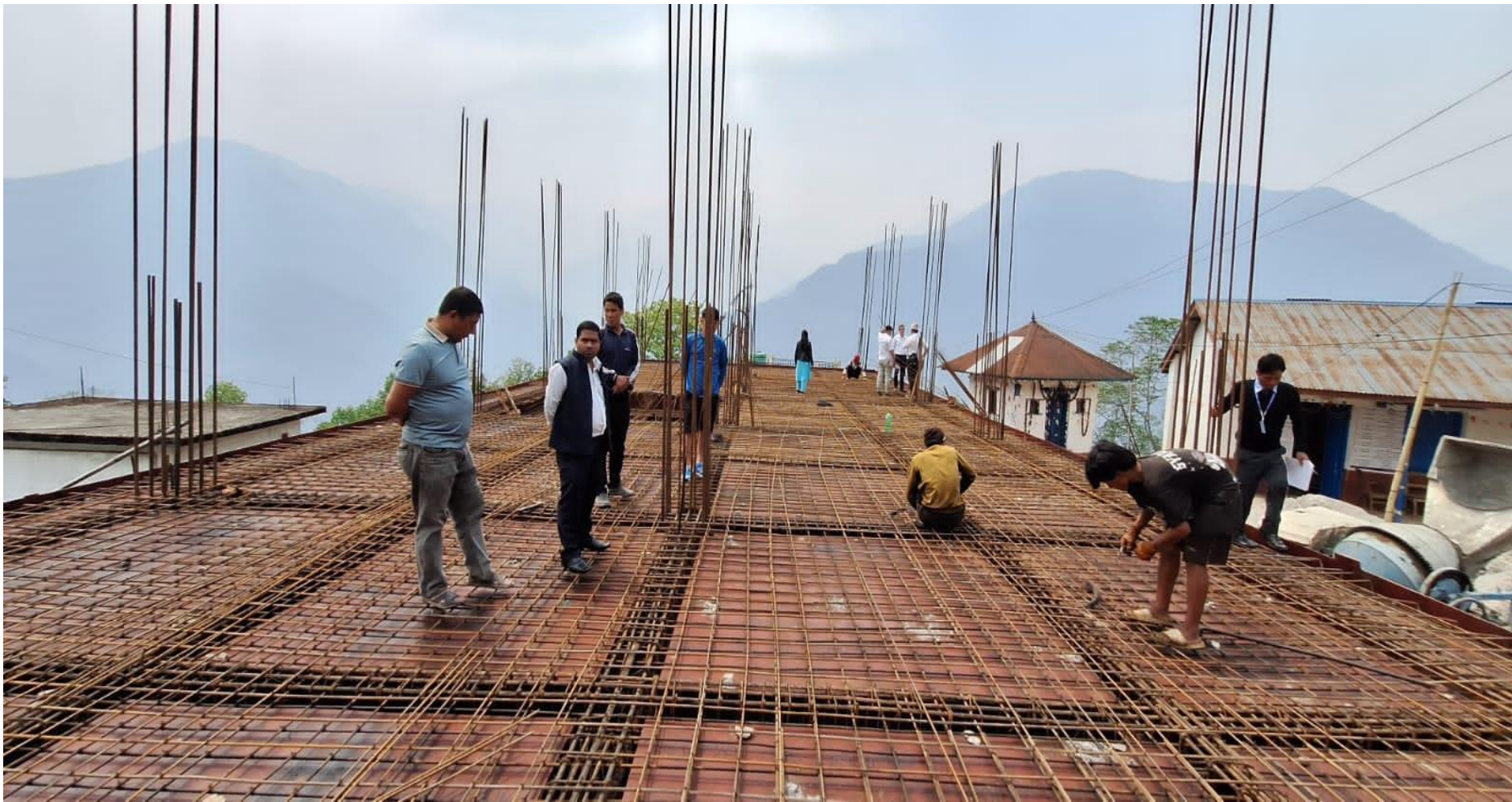
बिद्यालय भवन ढलानको लागि तयारी
