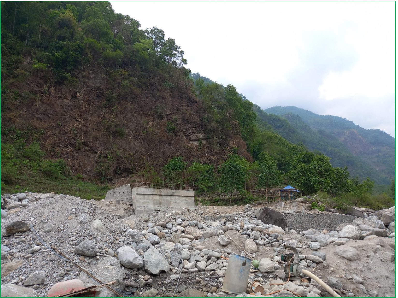
निर्माणाधिन सिसुवाखोला मोटरेवल पुल
