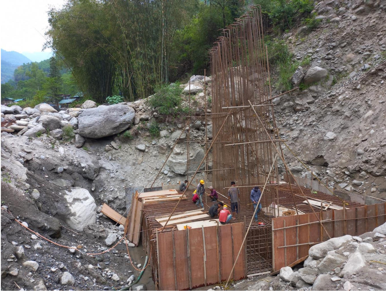
निर्माणाधिन सिसुवाखोला मोटरेवल पुल
